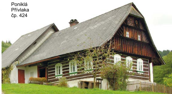
Sedlová střecha s námětky.
