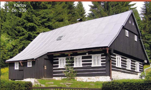
Krytá bedněné zádveří pod spuštěnou střechou je prvek běžný jak v Jizerských horách, tak v Krkonoších.
