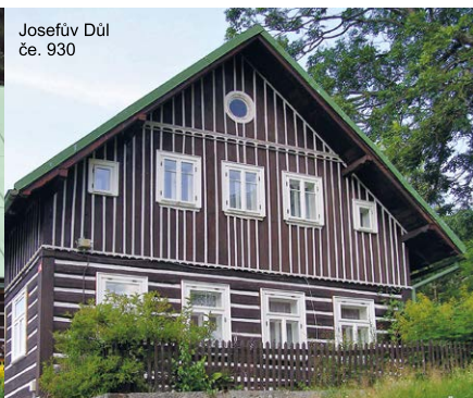
Domy z přelomu 19. a 20. století mají okna zpravidla větší, zejména pak ve štítě, což souvisí se zobytněním podkrovní. Trojice větších oken je pak charakteristická pro Jizerské hory. Josefův Důl čp. 930
