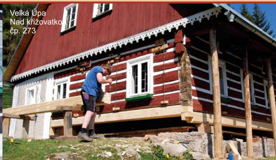
Výměna spodních trámů roubení v úrovni podlahy.
