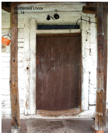
Názorný příklad jednoduché konstrukce dveřního otvoru v roubené stěně, kdy sloupky jsou zároveň zárubeňmi.
