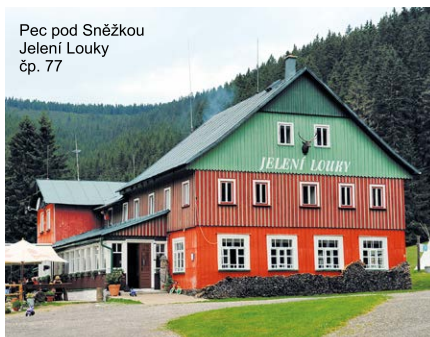
Prvky lidové architektury přenesené na domy pro hosty.
