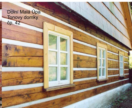
Vydařená celková výměna roubení.
