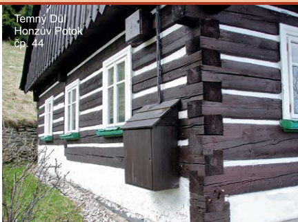
Chybné nahrazení roubení vyzdívkou.
