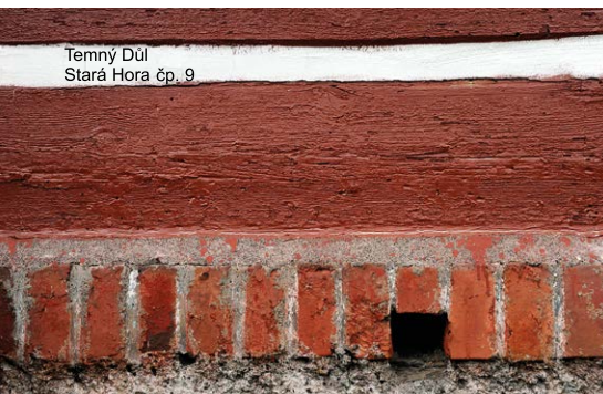
Kamenný základ s odvětráním podlahy zarovnaný cihlami.
