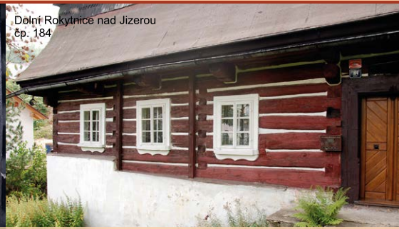
Roubení z nepravidelně tesaných trámů se třemi příčnými stěnami.
