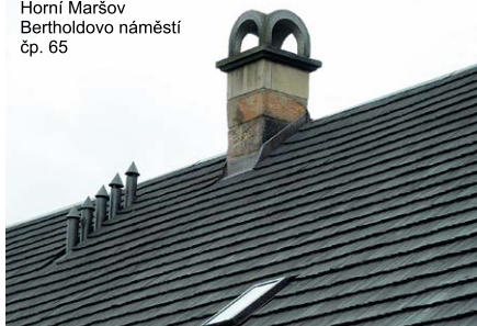
Klempířská střešní okna, tradiční komín a odvětrání vyvedené k hřebeni střechy.
