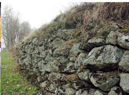
Potřebujeme-li vyrovnat terén, nejlepším řešením je terasní zídka z nasucho skládaného kamení místního původu.
