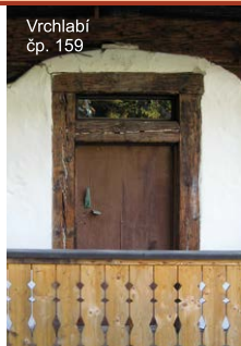
Trámová zárubeň ze zděné stěně.
