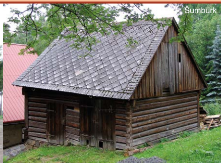
Roubená stodůlka větraná nevyplněnými spárami.
