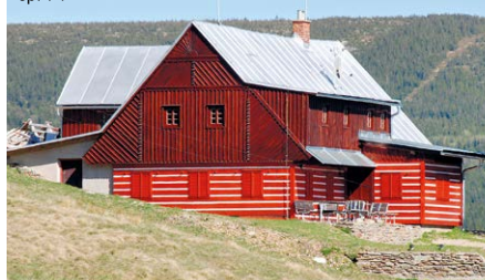
Nevhodně prosvětlené podkroví průběžným plochým vikýřem, nevhodné „falešné“ roubení na dřevníku.
