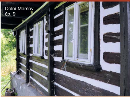
Roubení zpevněné přilžkami neboli stěnovými kleštinami.
