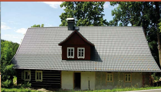
Vlnitý plech s desénem pálených či betonových tašek není z estetických důvodů pro Krkonoše a Jizerské hory vhodnou krytinou.
