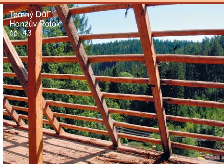
Detail dvojité stolice podpiřající hambalky a krokve.
